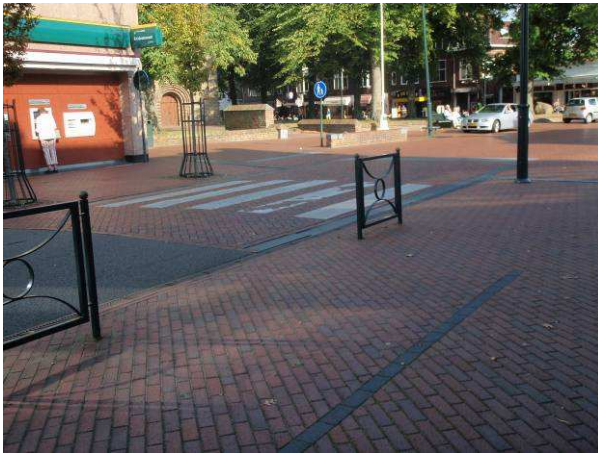
Figure 14 - Rijksweg, Haren - Shared Space
