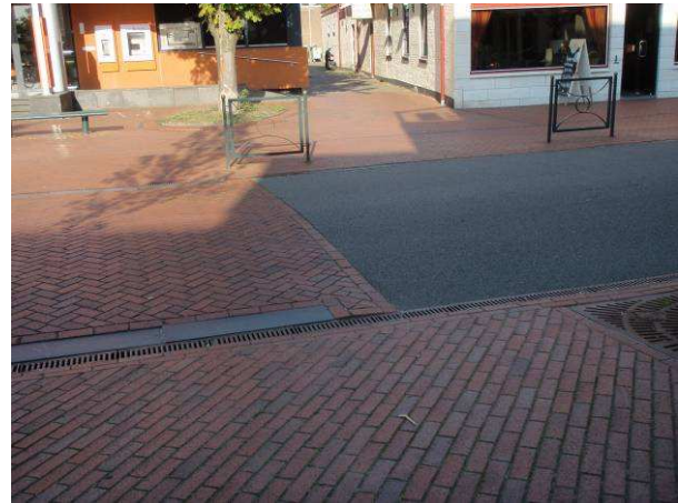
Figure 15 - Rijksweg, Haren - Shared Space
